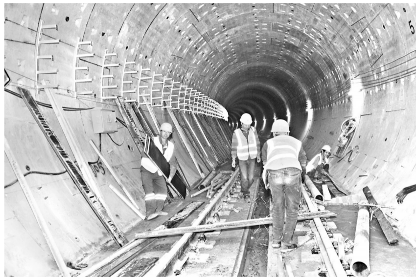
轨道开始铺设
